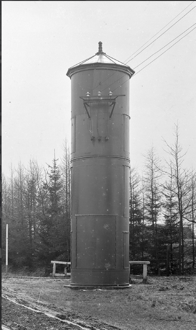
AFBEELDING: Een aparte, extra hoge transformatorzuil van HEEMAF Bron: CO; 0464.2_10386
