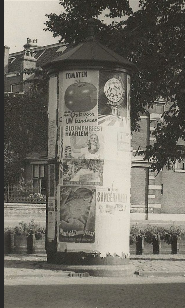
AFBEELDING: Een transformatorzuil aan de Leidsevaart Bron: HGA; 14138
