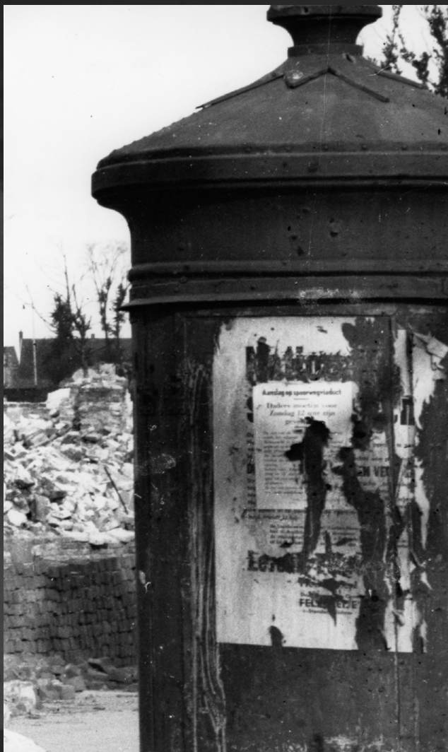
AFBEELDING: Fragment van een transformatorzuil op het Eusebiusplein in 1945 Bron: GA; 1560_5577
