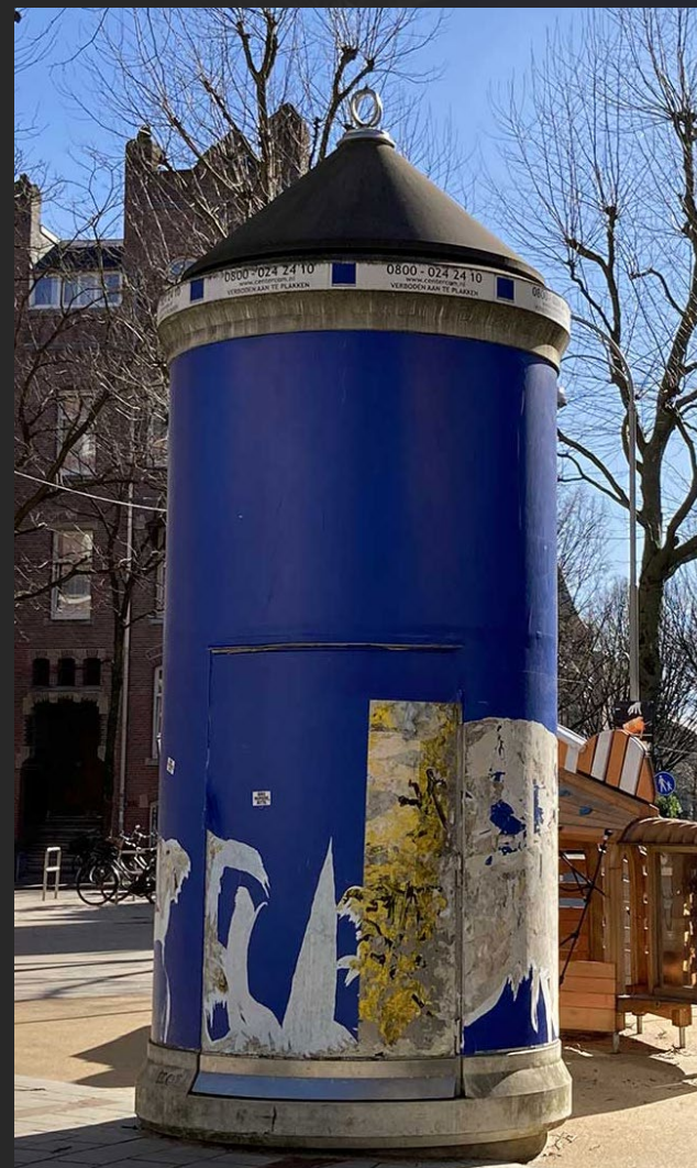
AFBEELDING: Een betonnen trafozuil op de Van de Veldestraat Bron: https://mforamsterdam.com/nl/amsterdamse-peperbussen/
