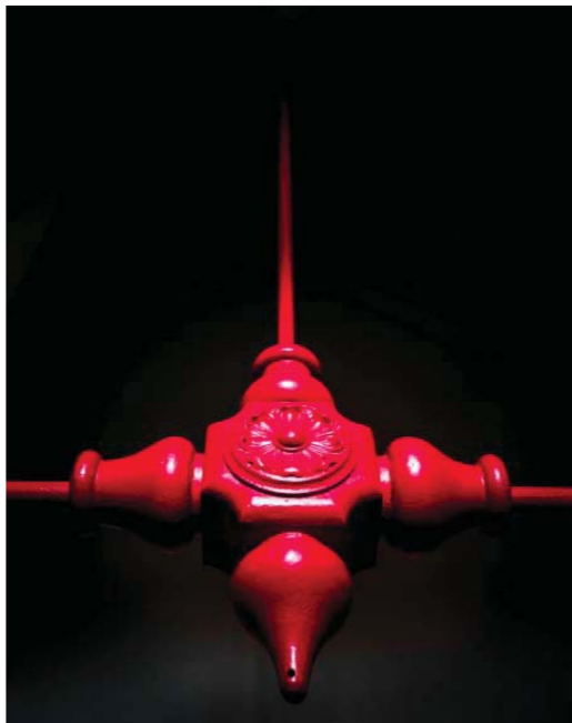
DETAIL AANSLUITING TREKSTAVEN
