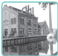
De watergasfabriek zoals die er oorspronkelijk bij stond met uitlaten van de ketels waar de cokes werden ontgast. Op de foto is zichtbaar dat er stoom uit het ketelhuis komt. Het ketelhuis is in 1948 aangepast en aan de achterzijde opgehoogd. Vermoedelijk is de schoorsteen ook in die tijd gesloopt.
