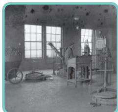
Een kijkje op de werkvloer op de eerste verdieping in de fabriek. Zie de overeenkomsten met de gravure van Humphreys & Glasgow. Ze zijn vrijwel identiek. De houten werkvloer was bedekt met stalen platen met een wafelijzer structuur. De fabriek had een capaciteit van 30.000 m<sup>3</sup> per etmaal.
